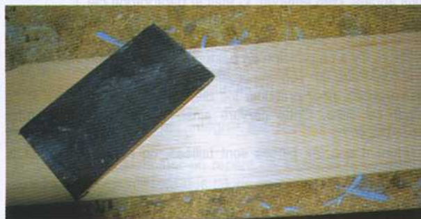
Méthode de ponçage des coffrages : précision et souplesse sont de rigueur.
