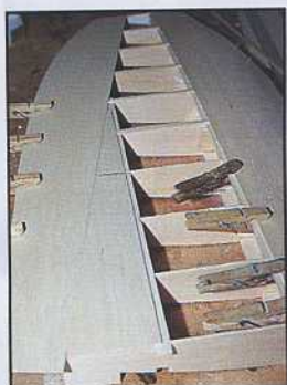
26) Pose du coffrage intermédiaire entre la partie arrière et le demi-longeron arrière.
