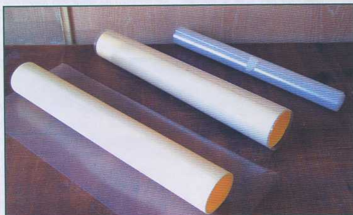
Noyaux en styro et film polyane servent à réaliser les conduites d'air F30 et 31.
