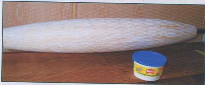
Application d'enduit pour moulures polystyrènes, type Perfax ou équivalent.
