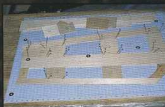
Préparation des coffrages partiels d'un stab.
